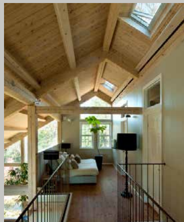
Strešné okná osadené do vlaškej sústavy za použitia nadkrokvovej izolácie.
