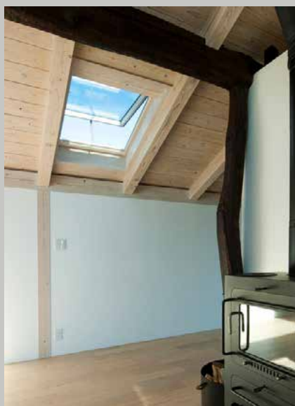
Samostatné osadenie medzi krokvami.
