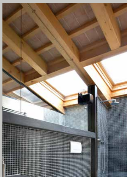
Výmena umožňuje použiť strešné okno väčšej veľkosti.
