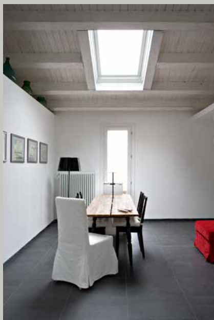
Strešné okná osadené do vlaškej sústavy za použitia nadkrokvovej izolácie.
